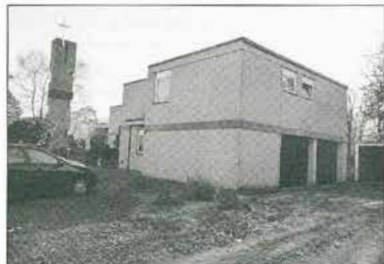
Abgebrochen: Appartement Hauffstraße 103
